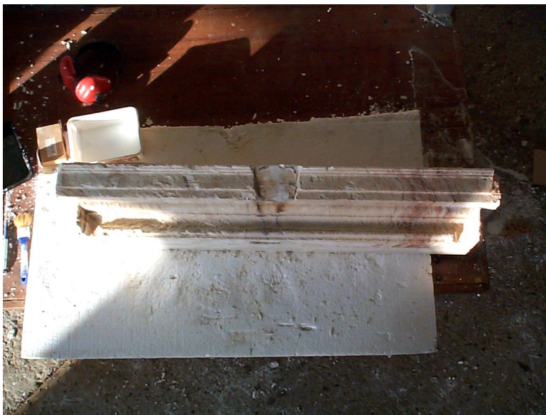
een van de originele onderdelen met zware oppervlakteschade
