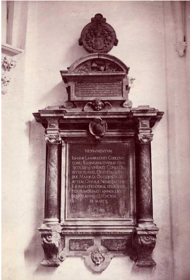
Het reeds incomplete en beschadigde epitaaf, ca 1890 (coll. St Jacobskerk, Vlissingen)
